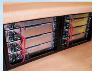
待合室 椅子下スペースに 蓄電池を配置 ※電池が見える様に前面カバーを外して撮影しております
